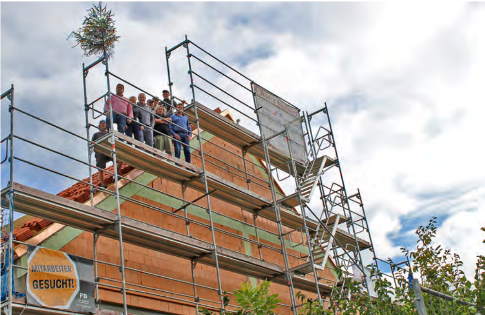
Neben den Mitarbeitern der beteiligten Firmen nahmen am Richtfest Bürgermeister Hans Anderl, 3. Bürgermeister Hans Laumer, Evi Kienberger (Bauleiterin Gutthann HIW Architekten), Herr Rothenwührer (Ingenieurbüro Rothenwührer) teil.
